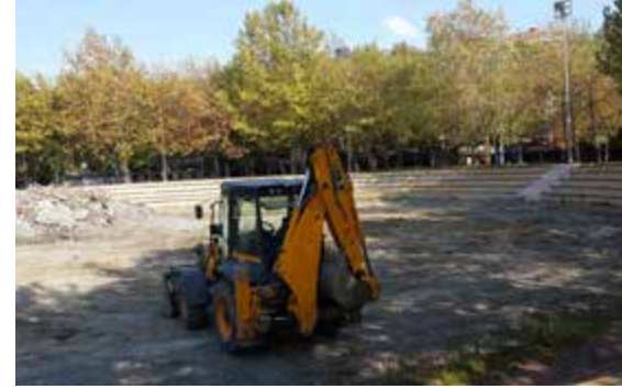
Bakım, Onarım Çalışması Ambarlı Mahallesi, Sahil Güreş Alanı - Öncesi
