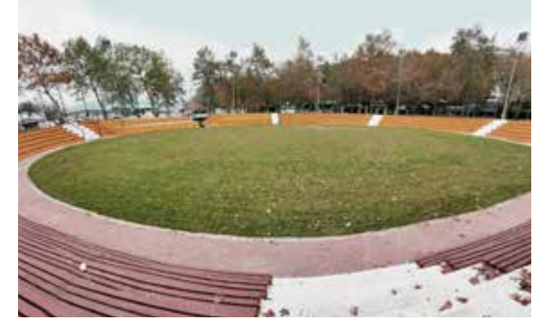
Bakım, Onarım Çalışması Ambarlı Mahallesi, Sahil Güreş Alanı - Sonrası
