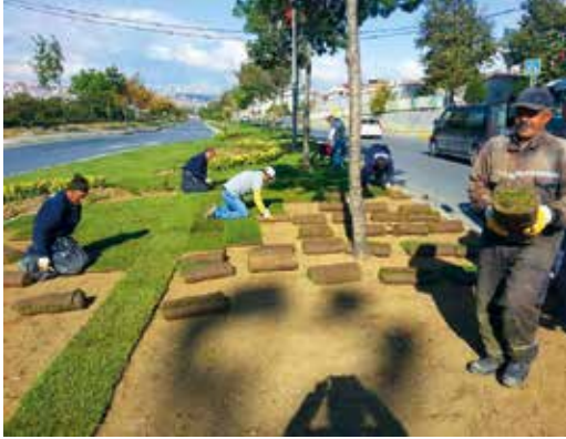
Ambarlı Mahallesi Tesisler Yolu Çim serme çalışmalarımız.
