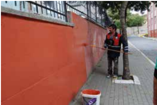
Nihat Candarlı Ortaokulu Bahçe duvarı boyanması
