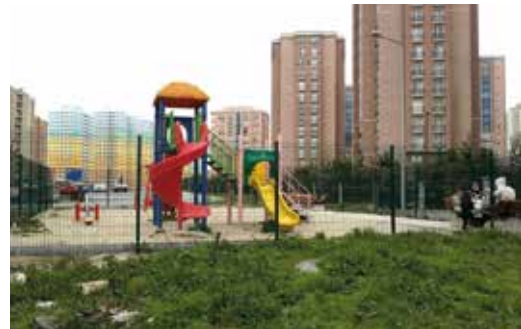
Tahtakale Mah. Vadi Park Çocuk Oyun Alanı Park Yapım Çalışmamız
