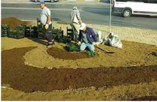
Ambarlı Mahallesi Tesisler Yolu Bitkilendirme çalışmalarımız / Eski Hali
