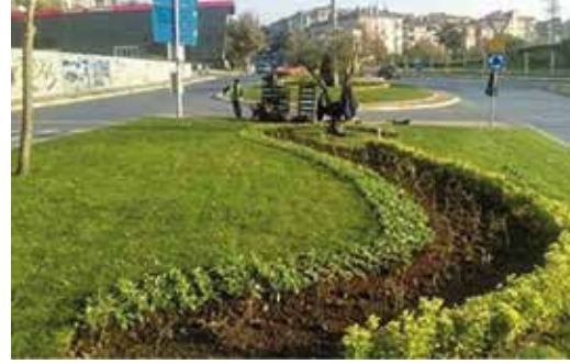
Ambarlı Mahallesi Tesisler Yolu Bitkilendirme çalışmalarımız / Güncel Hali
