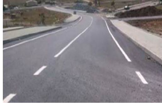
17- Firuzköy Mah. Balcıbük Caddesi'nde Yapılan Asfalt Çalışması
