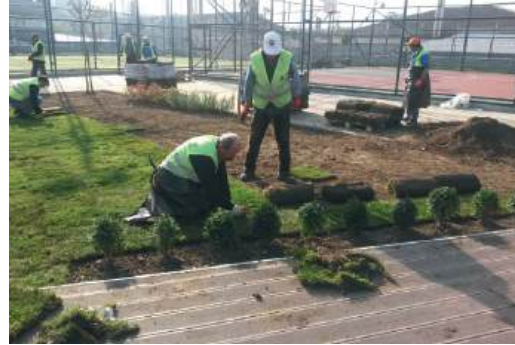
24- Cihangir Mahallesi Osman Özbek Parkı Çim Serilmesi
