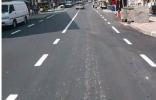
16- Yeşilkent Mah. Balık Yolu Caddesi'nde Yapılan Asfalt Çalışması
