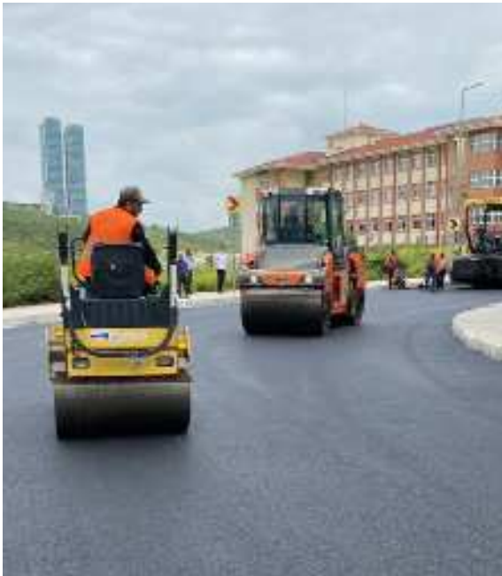
Sıcak Asfalt Kaplama Çalışmaları
