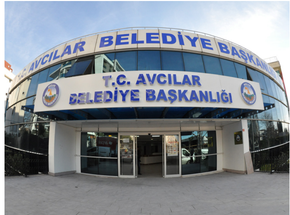
[A-Blok] Belediye Hizmet Binası
