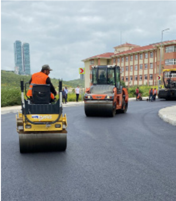
Sıcak Asfalt Kaplama Çalışmaları
