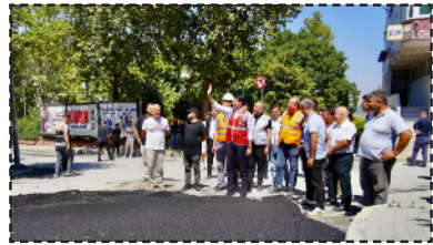
Menekşe Sokak Asfalt serimi çalışması
