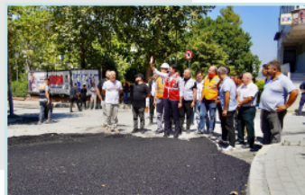
Merkez Mahallesi Menekşe Sokak' ta asfalt serimi çalışmamızı yerinde inceledik.
