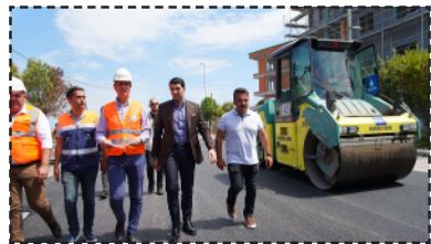
Asfalt Çalışması Yol yenileme çalışması
